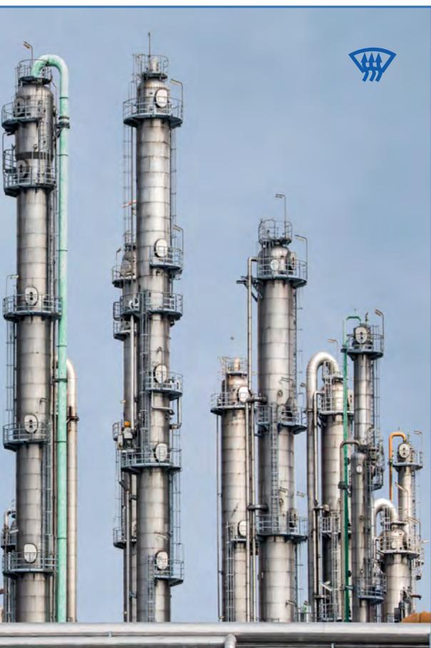
Les colonnes à garnissage sont de plus en plus utilisées dans une variété d'applications dans les industries des procédés chimiques , telles que le lavage, la distillation et la précipitation.
