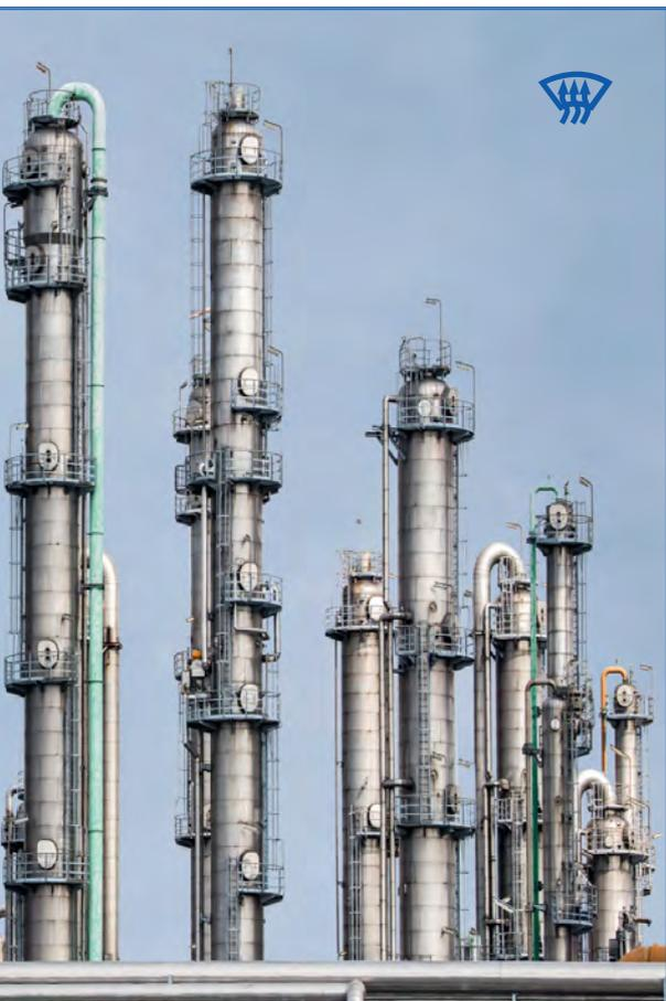
Verpackte Türme werden zunehmend in verschiedenen Anwendungen in der chemischen Prozessindustrie eingesetzt, wie zum Beispiel Absorption, Destillation und Fällung.
